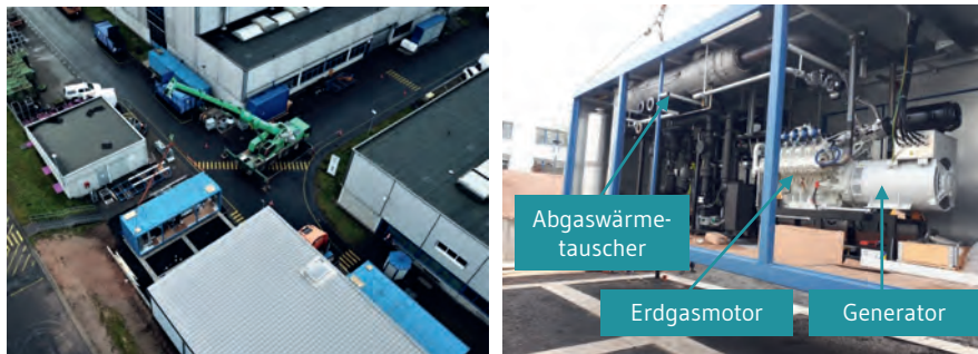
Abb. 9 Aufstellung des Doppel-BHKW (l.) und Aufbau BHKW-Container (r.)
