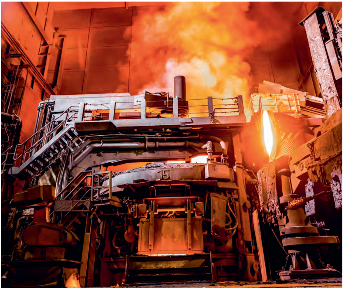
Abb. 1 Ansicht des Elektrolichtbogenofens im DEW-Werk Siegen
