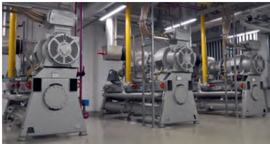
Abb. 1 \text{NH}_3 -Kältemaschine (l.) eines Salzbeckens (r.) (DMK Group, VDI 2021)
